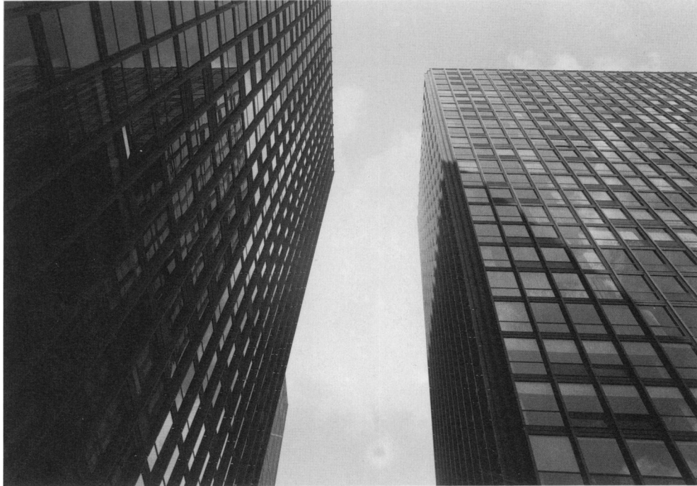
39 Federal Center, Chicago, 1964, Mies van der Rohe
